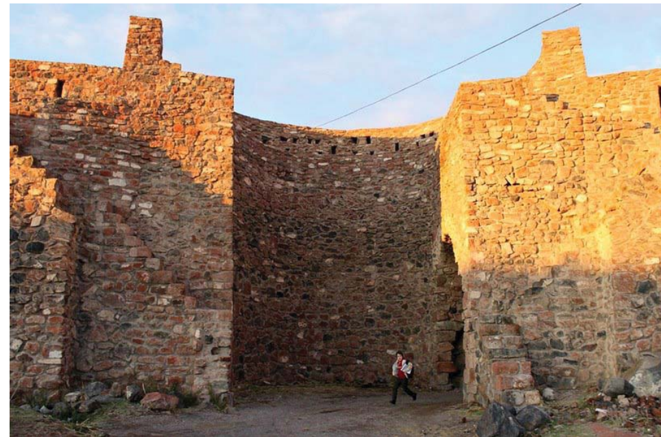
1812-ci ildə Aşağı Talın kəndindəki qala üçün İrəvan xanının tikdirdiyi iri bazalt daşından hörülmüş şəhər divarı
