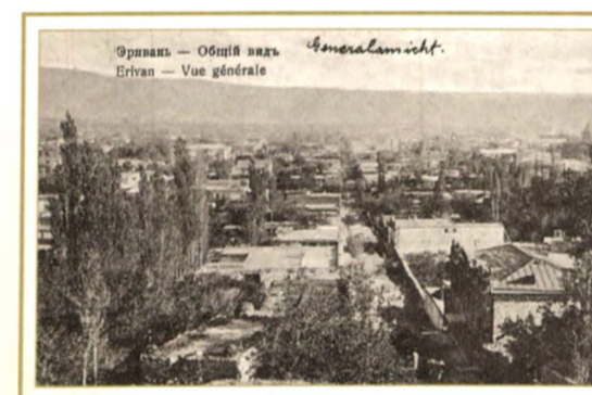
Zəngi çayı üzərindəki su dəyirmanından Təpəbaşı məhəlləsinin ümumi görünüşü. G.Tarverdyan. 1900–1903-cü illər Общий вид квартала Тепебаши от водяной мельницы на реке Занги. Г.Тарвердян. 1900–1903 годы General view of Tepebashi neighborhood from the water mill on Zangi river. G.Tarverdyan. 1900–1903 years
