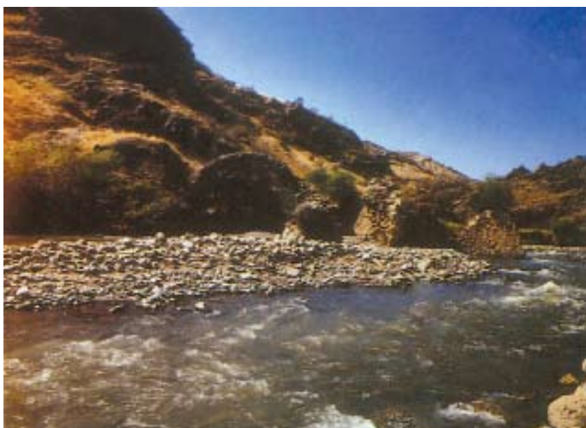
Laçının Aşağı Fərəcan ərəzisinə çoxtaġlı körpü
