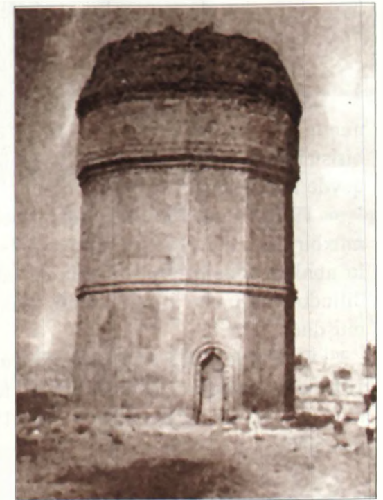
Cəfərabad//Pir Hüseyin türbəsi gümbəzi dağılmış halda.
