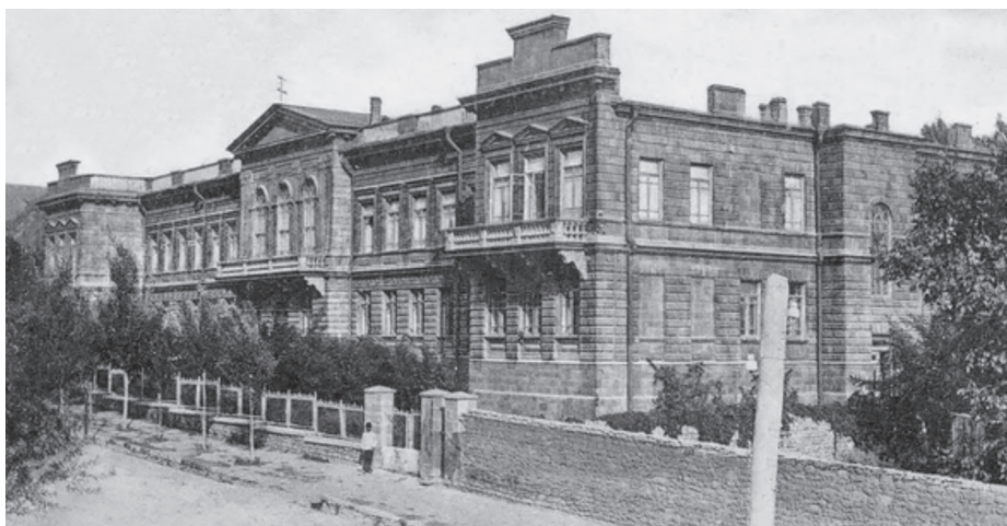
İrəvan Müəllimlər Seminariyası 1905-1915-ci illərdə bu binada yerləşmişdir
